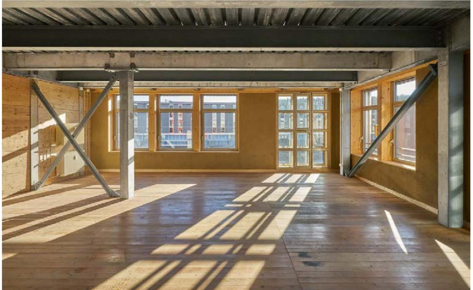
B4.35 Diverses fenêtres réutilisées, des radiateurs recyclés montés les uns sur les autres, du parquet usagé et des poutres en acier qui soutenaient autrefois un autre bâtiment, de Baubüro In Situ.
